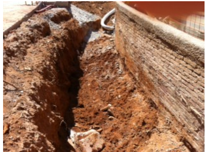
28. Espai ocupat per l'estructura, un cop retirada.
