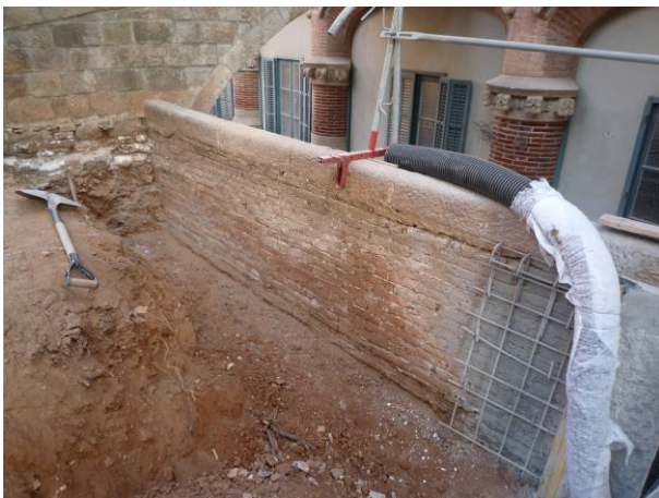
11. Excavació fase 2 a l'exterior del pati 2 finalitzada
