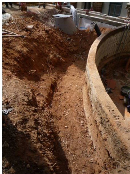
12. Excavació fase 2 a l'exterior del pati 3 finalitzada
