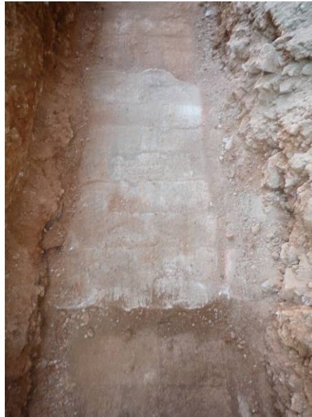
8. Reparació UE 136 de la coberta del col·lector UE 125
