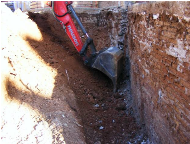
3. Rebaixos de la fase 1 al costat dels patis 1 i 2
