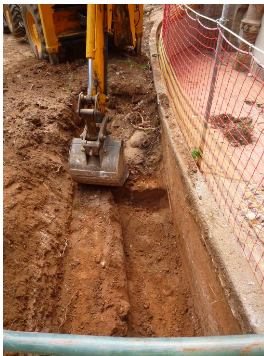
Excavació de la rasa al costat del pati 2.
