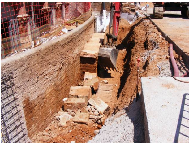
27. Retirada de les estructures UE: 119, 120, 117, 115, 116, 113, 114, 111, 112, 109, 108
