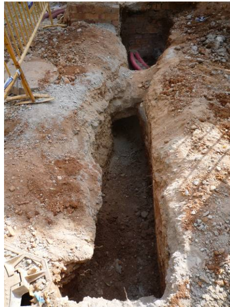
20. Rasa pel drenatge de les arquetes
