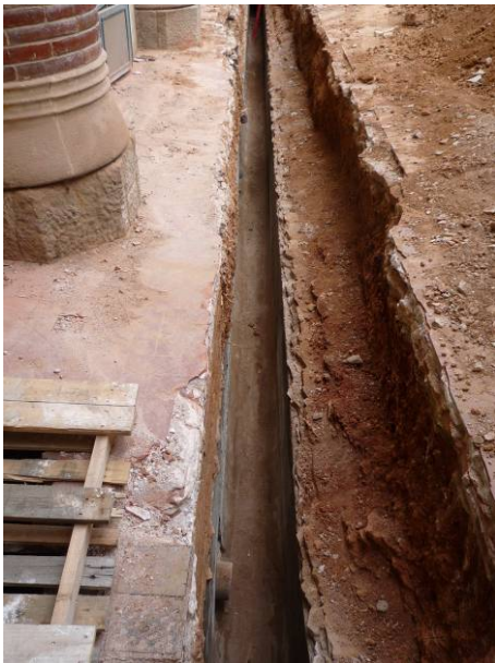
9. Col·lector Ue 125 amb la coberta desmuntada
