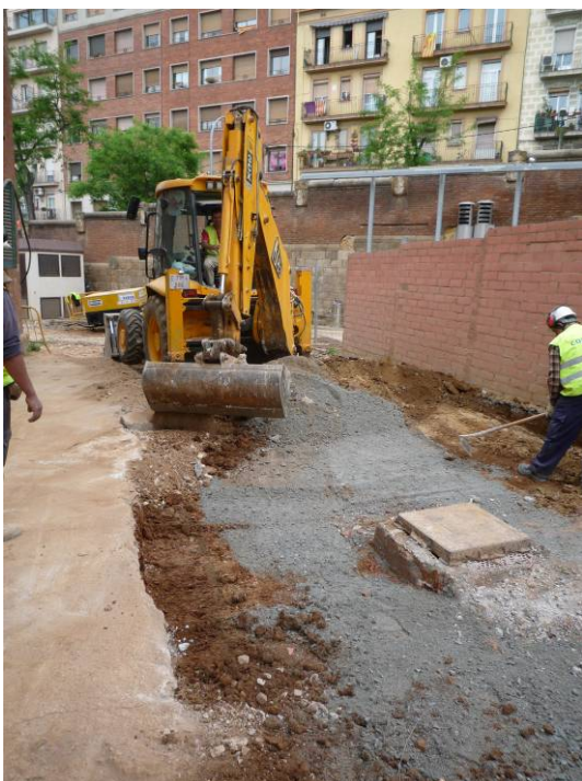
Excavació del calaix.
