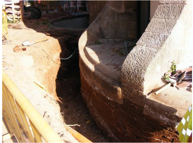
6. . Excavació fase 1 a l'exterior del pati 4 finalitzada
