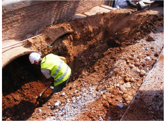
22. Neteja de l'estructura de voltes per a la seva documentació
