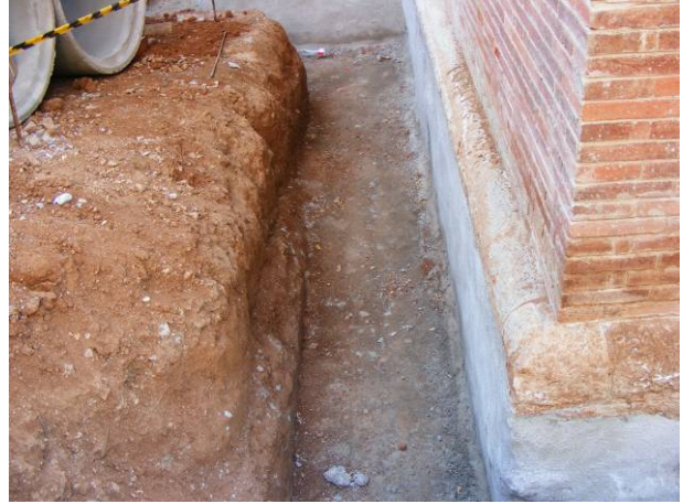
14. Rasa tocant la façana oest del pavelló de Santa Apol·lònia
