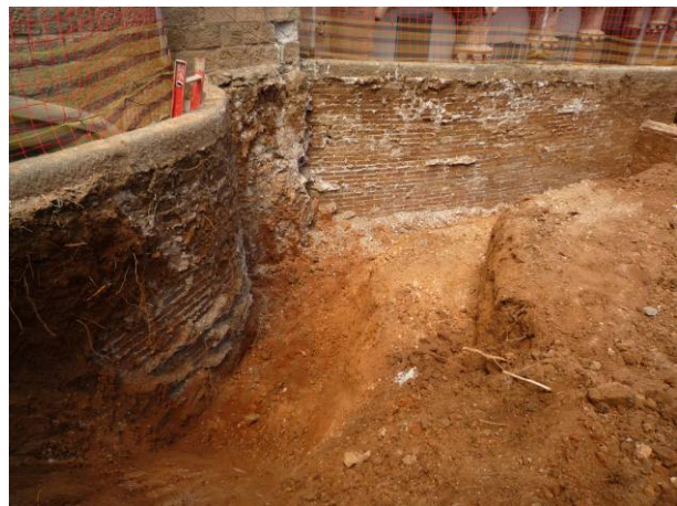
4. Excavació fase 1 a l'exterior dels patis 1 i 2 finalitzada.
