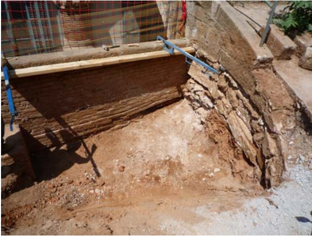
5. Excavació fase 1 a l'exterior dels patis 2 i 3 finalitzada
