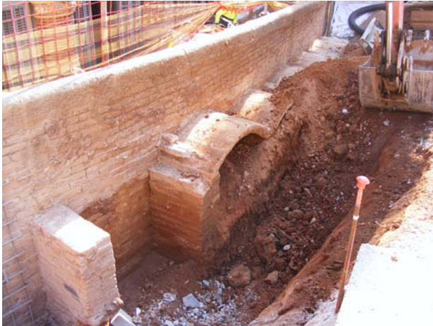
21. Realització d'una rasa davant de l'estructura de voltes per a la seva documentació.
