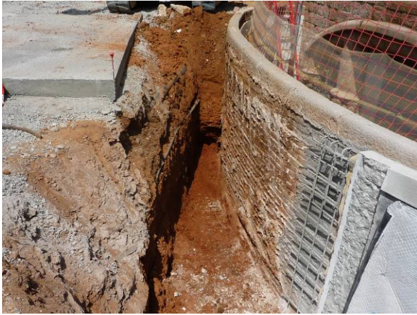
13. Excavació fase 2 a l'exterior del pati 1 finalitzada
