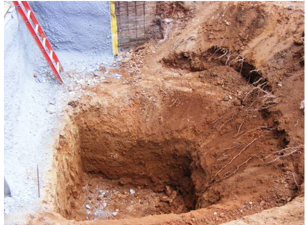
10. Excavació de un dels pous finalitzada
